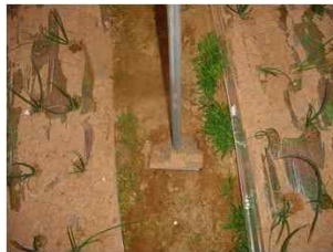
보강지주 하단의 바닥지지판(마르고 다져진 토양의 경우, 직경 10~12mm 이상)
