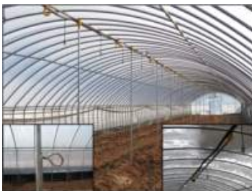
<보강지주 설치 전경>
