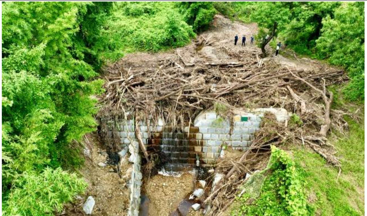
<전북 익산시 함라면 사방댐 시설지 산사태 예방 사례>
